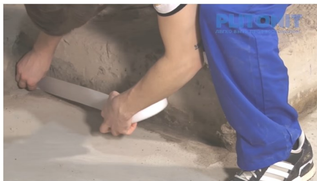
Рис.3. Приклеивание демпферной ленты
