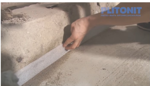
Рис.3. Приклеивание демпферной ленты
