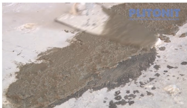
Рис.2. Ремонт трещин
