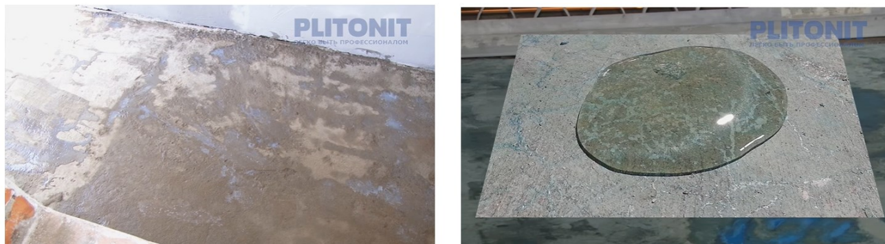
Рис.4. Обработка основания грунтовкой
