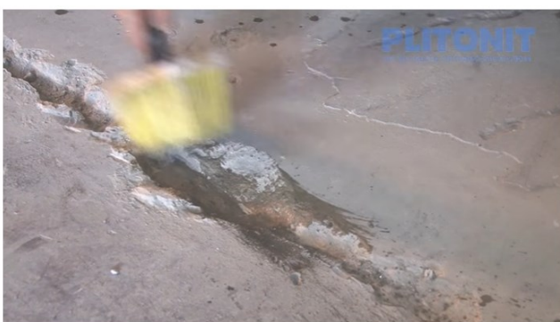
Рис.2. Ремонт трещин
